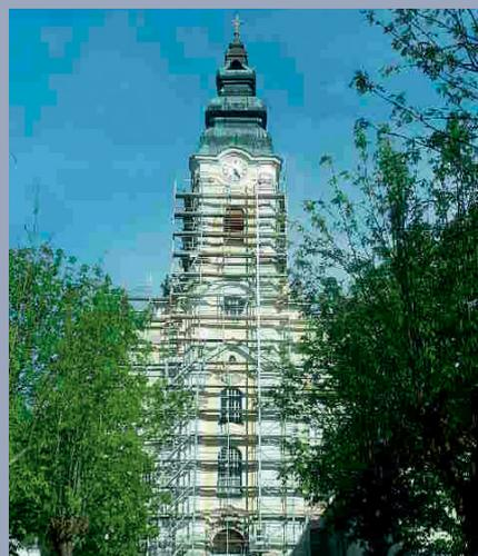
blechen, Steinmetzarbeiten, die Erneuerung des Blitzschutzes und die Restaurierung von Zierfiguren und der Turmuhr.
