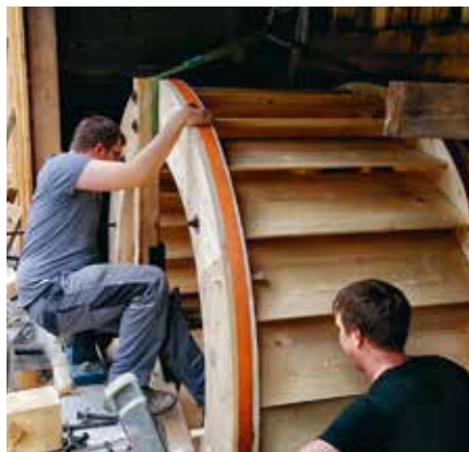
Vom 1:10-Modell zum neuen Wasserrad.
